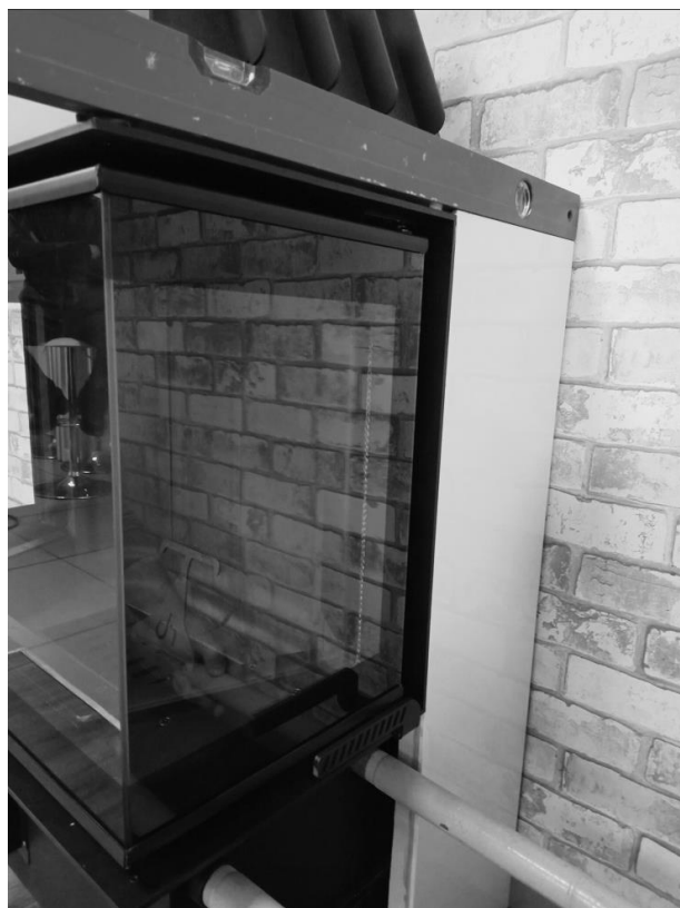
Rysunek 8. Szczelina dylatacyjna
