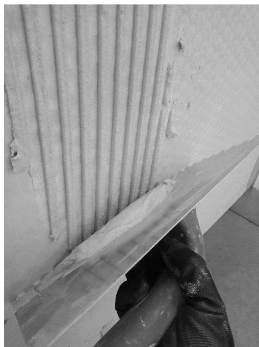
Rysunek 6. Nakładanie kleju wysokotemperaturowego
