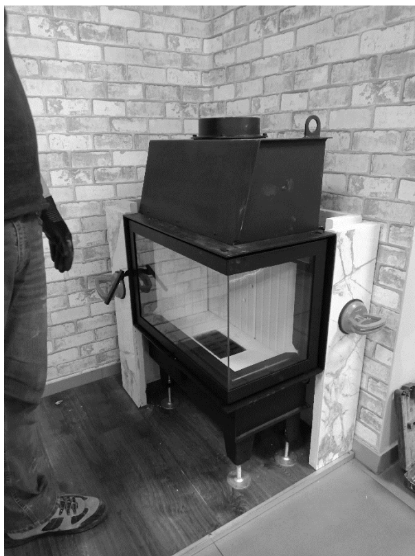
Rysunek 7. Ustawienie pierwszego modułu
