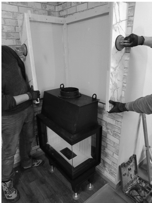
Rysunek 5. Sposób ułożenia pierwszego modułu.
