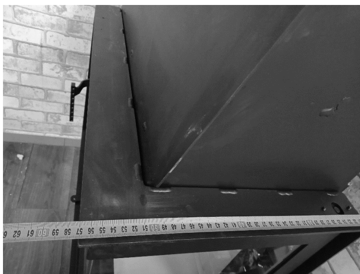
Rysunek 4. Ustawienie wkładu kominkowego.
