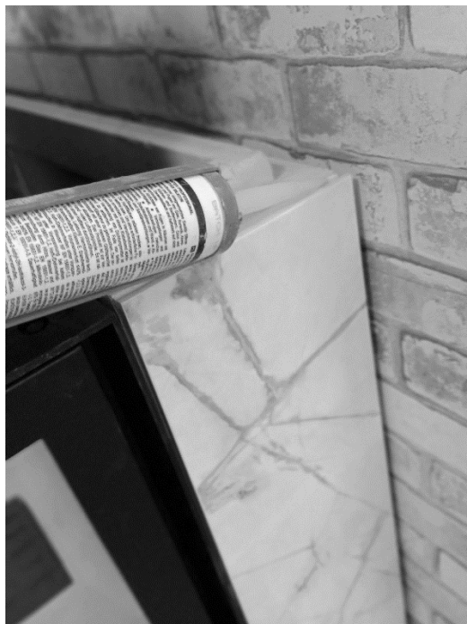
Rysunek 9. Nakładanie kleju wysokotemperaturowego na krawędzie modułu
