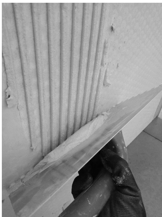
Rysunek 6. Nakładanie kleju wysokotemperaturowego
