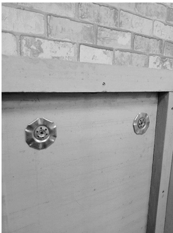
Rysunek 10. Sposób zakotwienia modułu
