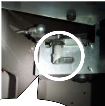
дверь остановлена для обслуживания
