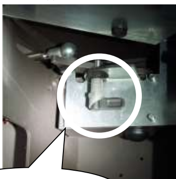
дверь остановлена для обслуживания
